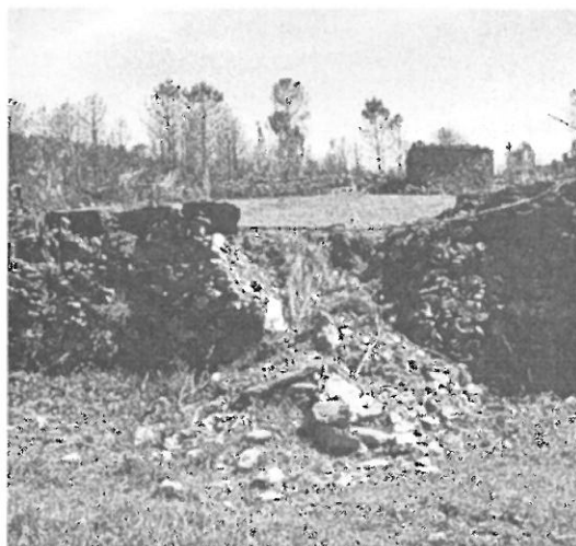
Foto 7 Pormenor do desmoronamento de um muro de suporte numa área xistosa, Colcurinho, Aldeia das Dez. Fonte: NICIF
