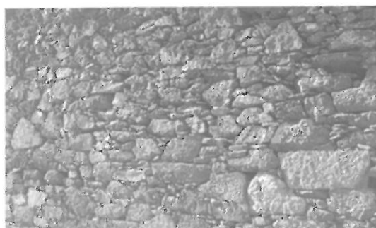
Fotografia 11 Muro com algum aparelhamento, Teixeira de Cima
