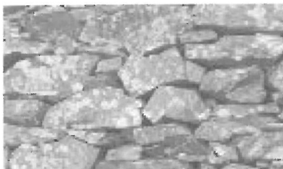
Fotografia 10 Muro com pouco aparelhamento, Porto Silvado
