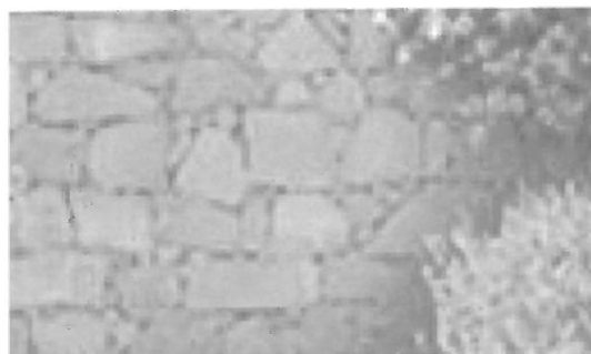
Fotografia 12 Muro poligonal, Aldeia das Dez
