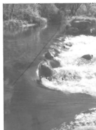
Fotografia 31 Pormenor de açude, Ribeira do Avelar
