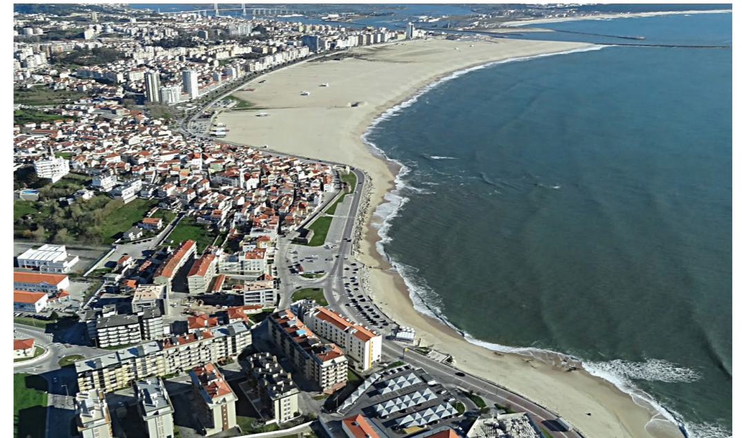
Figure 23 - Érosion à Buarcos.
