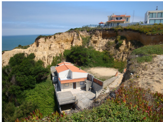
Figure 39 - Glissement de terrain.
