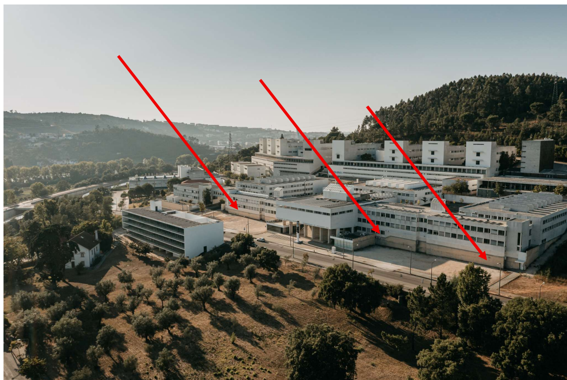
Figura 1 – Vista geral do DEC – Paredes dos parques de estacionamento
