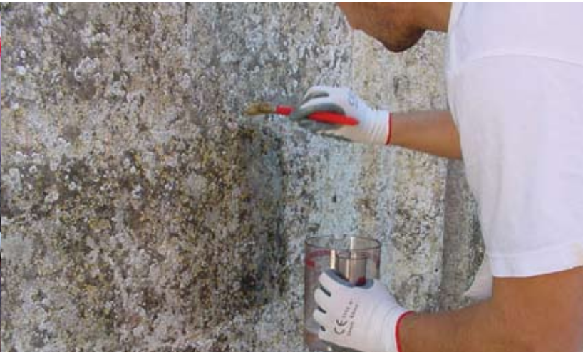
☑ Aplicação de produto biocida em janelas de ensaio, GCU, 2007 Application of biocide product in test patches, GCU, 2007
