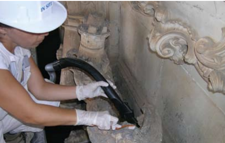
☒ Segunda fase, testes de limpeza do grupo escultórico por aspiração, GCU, 2007 Second phase: cleaning tests of the sculptural group by vacuuming, GCU, 2007
