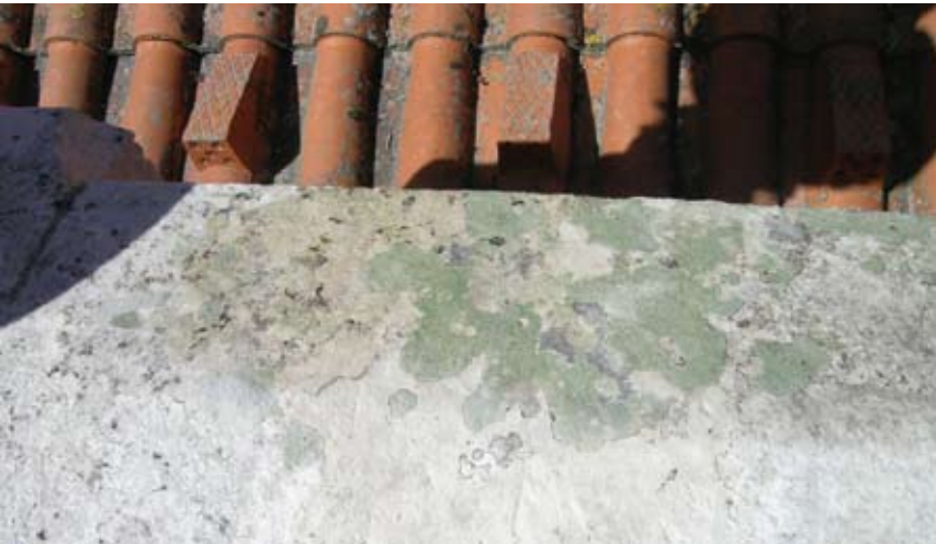
☒ Reaparecimento de algas após a primeira aplicação de biocida, GCU, 2009 Reappearance of algae after the first application of biocide, GCU, 2009
