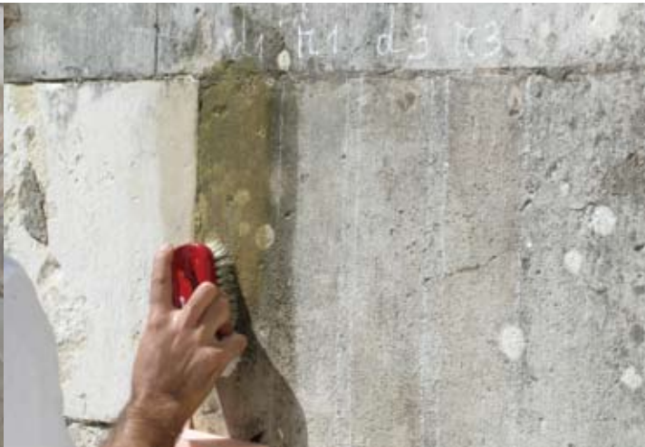
☒ Segunda fase, testes de limpeza: selecção de biocidas, GCU, 2007 Second phase: cleaning tests – selection of biocides, GCU, 2007
