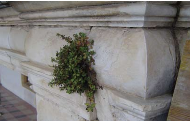
☒ Presença de vegetação superior nas juntas, GCU, 2006 Surface vegetation in joints, GCU, 2006
