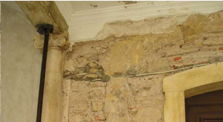
☒ Primeira fase, zona de picagem de reboco onde ficaram à vista elementos em cantaria de vãos preexistentes, GCU, 2004 First phase: scabbled area where stonemasonry of pre-existing openings became visible, GCU, 2004
