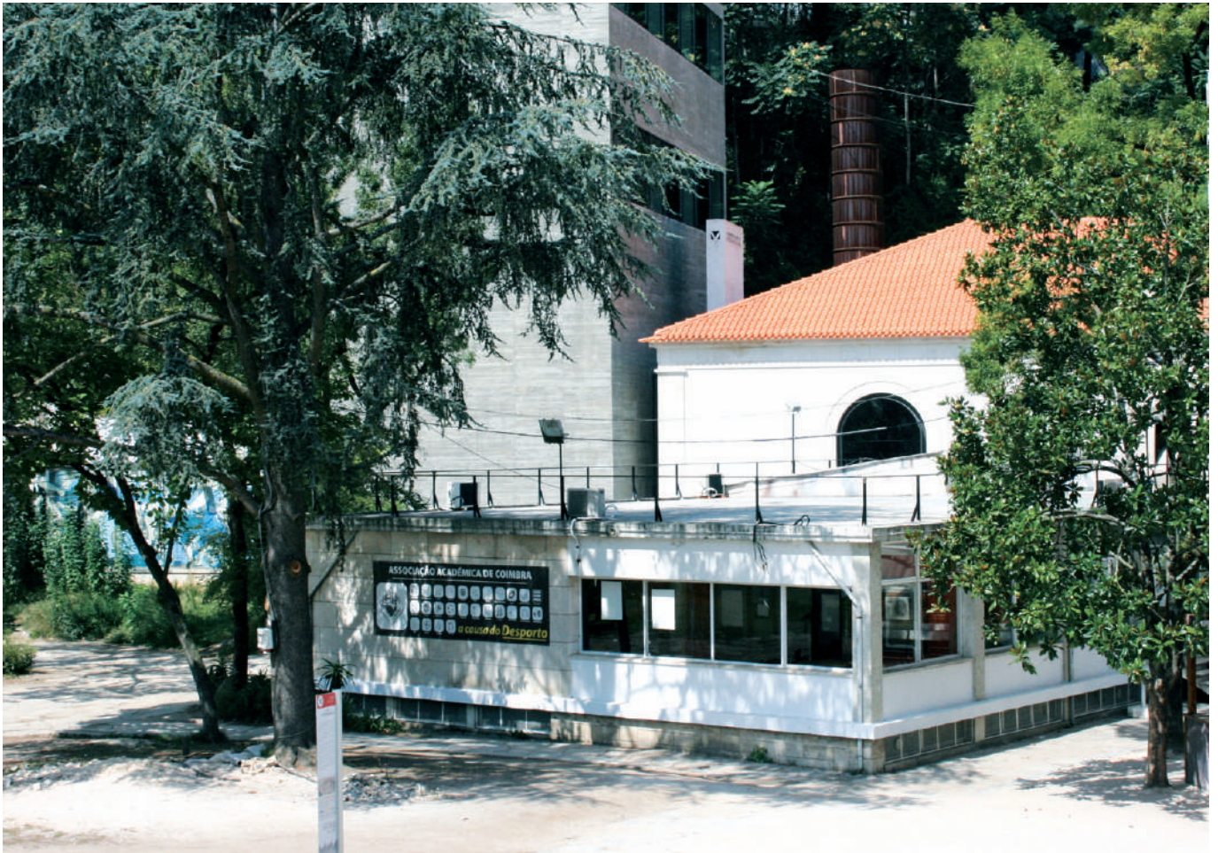
☑ Edifício das Caldeiras após a intervenção, visto dos Jardins da AAC, CM, 2009 Boiler House after intervention, viewed from the garden of the Coimbra Student Union, CM, 2009
