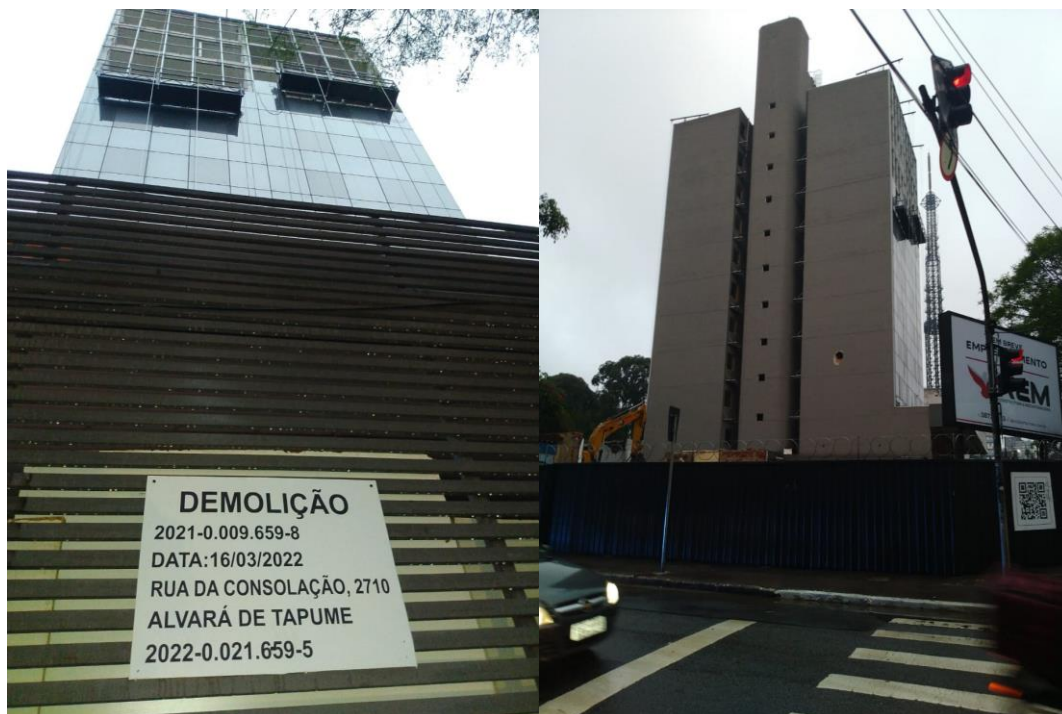
Figura 2- Demolição de prédio na cidade de São Paulo, impulsionada pela legislação permissiva, conduzida pelos interesses do capital imobiliário.
