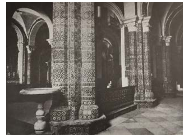
Fig. 1 — Interior da Sé Velha de Coimbra em 1890, antes da campanha de restauro de 1898-1918 [António de Vasconcelos, A Sé Velha de Coimbra , vol. I, Coimbra, 1930, Est. XXV]
