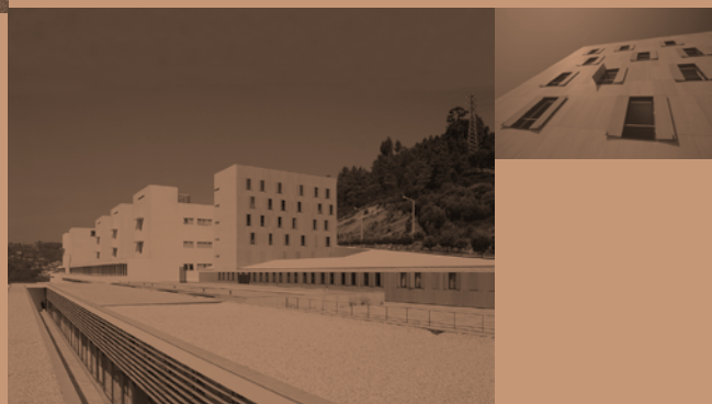
Residência e restaurante universitários, Polo II da Universidade de Coimbra, projeto dos arquitetos Manuel Mateus e Francisco Mateus.
